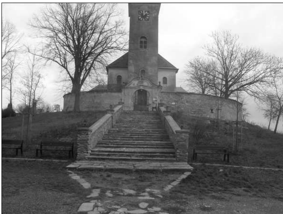
F16 – přístup ke kostelu
