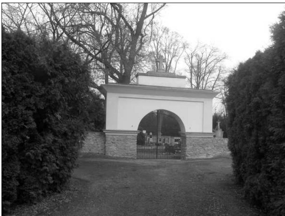
F4 – vstup na hřbitov
